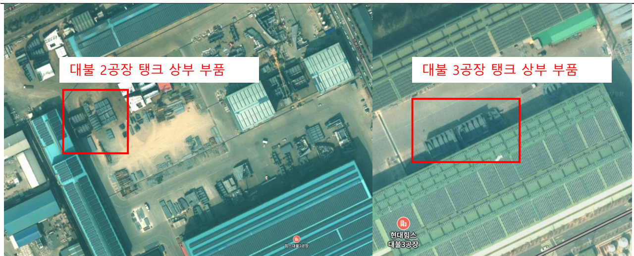
그림 2. 현대hips(HD현대삼호) 대불 2,3 공장 위성 지도: 올해부터 대불 4공장에서 탱크 하부~보온 공정까지 포함하여 연 3,5척의 탱크 제작 예정
