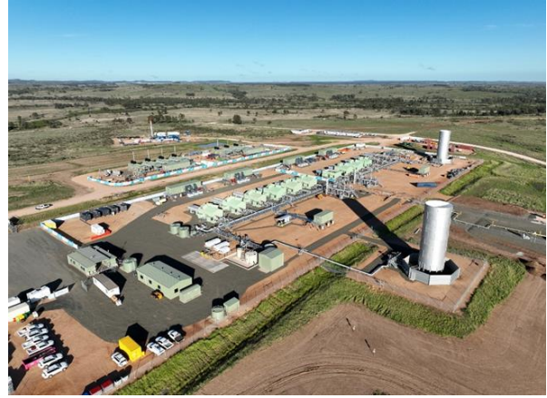
그림 2. SENEX 아틀라스 가스전 가스처리시설 전경
