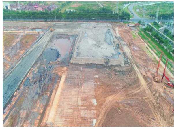
그림 4. Hyosung Vina Core Materials 부지 전경
